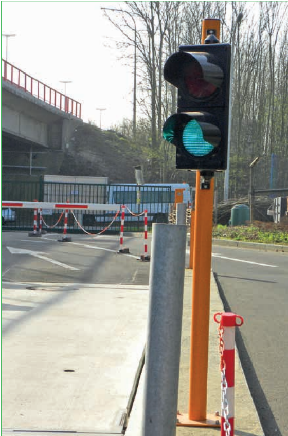
montage op ondergrond
